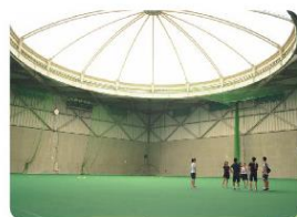
屋内運動場(ドーム)
